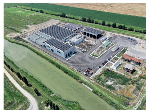
L'impianto a FORSU di Copparo (FE)
